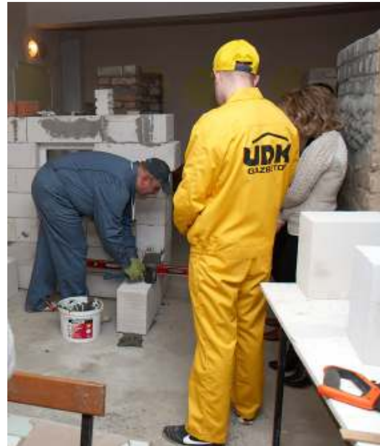
КЦШРКБГ, Мурування стін матеріалами UDK "GAZBETON"
